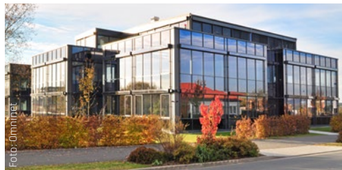
Das Firmengebäude von Omninet.
