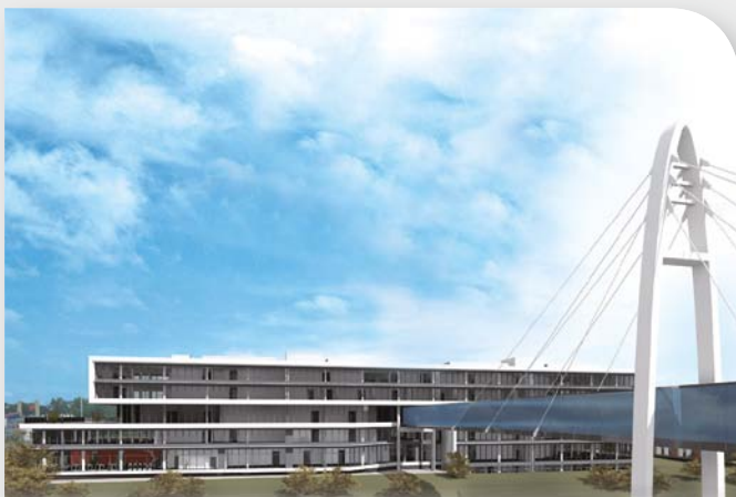
Erweiterungsbau der Puma Unternehmenszentrale – „Puma Bridge“, Herzogenaurach
